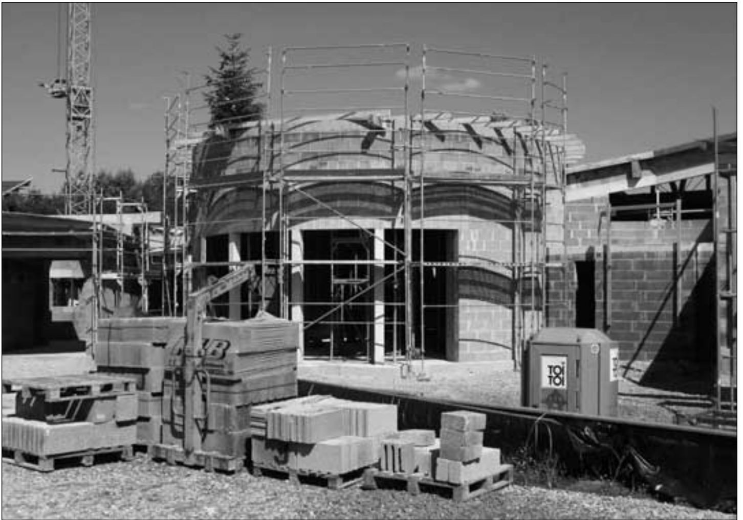
Der Rohbau des Hauses für Kind und Familie wächst. Im nächsten Sommer wird Einweihung gefeiert.
