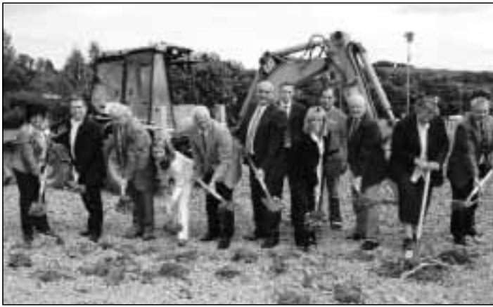
Mit dem ersten symbolischen Spatenstich hat der Neubau des Hauses für Kind und Familie begonnen.
